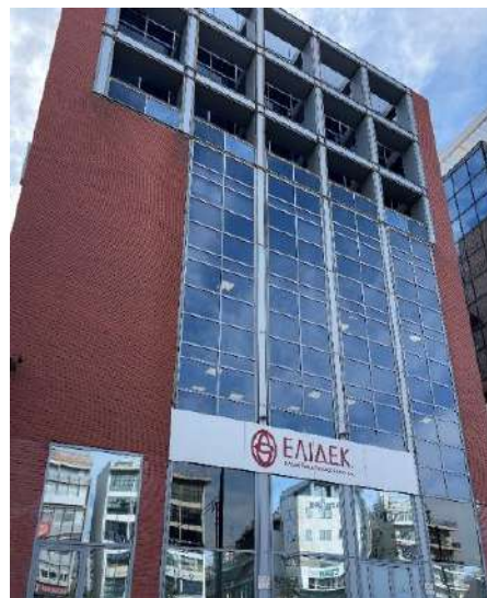
Σχήμα 3. Εξωτερικές εγκαταστάσεις ΕΛΙΔ.Ε.Κ.
